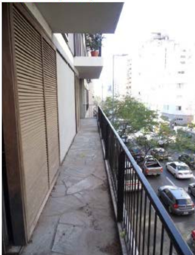
F22- Vista del balcón principal sobre Av. Colón.
