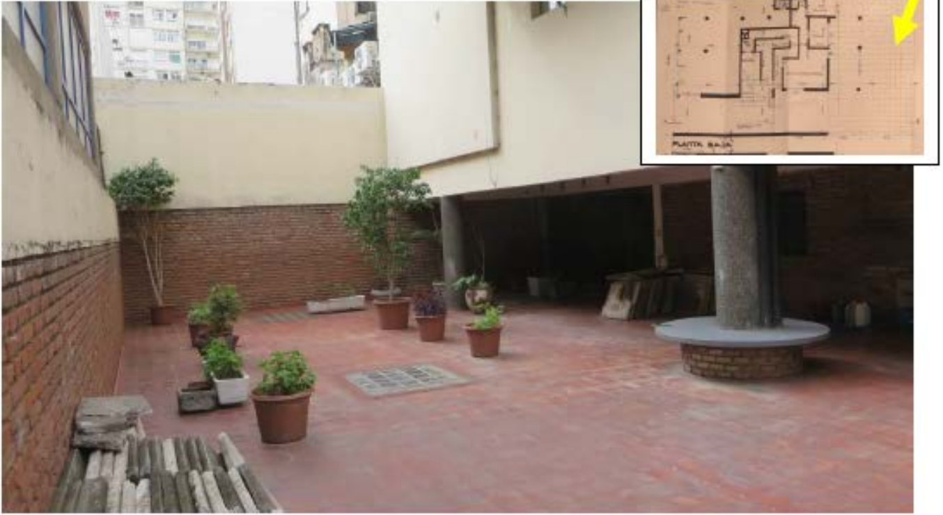
F7- Vista del patio principal de uso común del edificio a nivel de Planta Baja.
