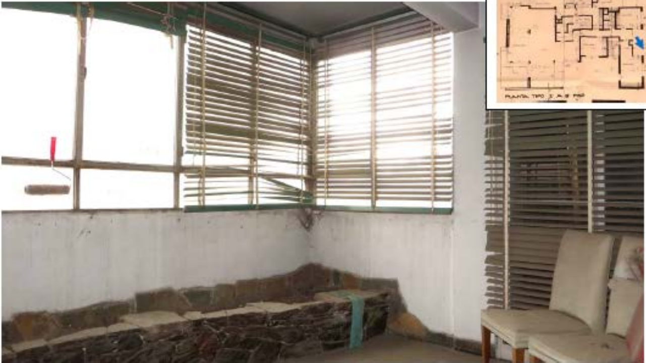
F19- Vista del patio luz cerrado que da a dormitorio principal.
