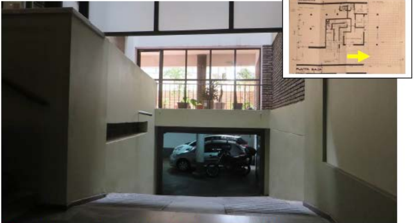
F5- Vista del acceso interno a cocheras de subsuelo desde el hall.
