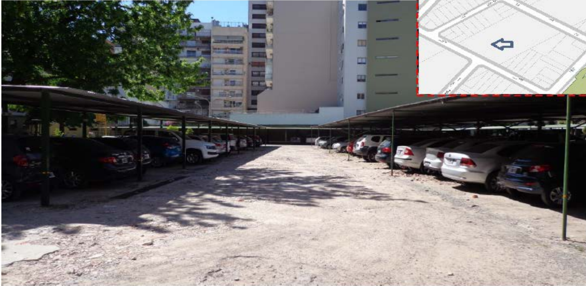
Cocheras Semi-Cubiertas Sector central del predio.
