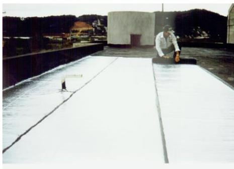
Los rollos de membrana deberán colocarse sucesivamente desde la parte más baja a la más alta. El primer rollo se colocará en forma perpendicular a la corriente de agua y se le dará un tiempo prudencial de estabilización, a efectos de que eliminen las ondulaciones propias del
