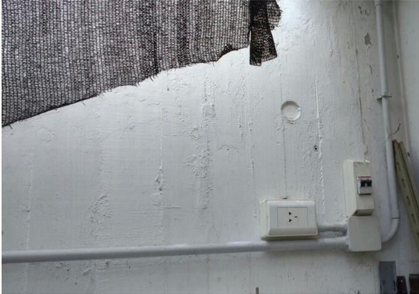
La evacuación de fluidos de condensación, serán realizadas por conducto plástico de desagote hacia la canaleta de descargas exterior. Este conducto será plástico de ½” y fijado a muro firmemente.
