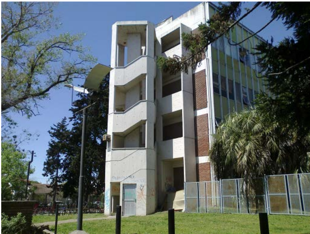
Escalera 1 / calle San Lorenzo 3916-
